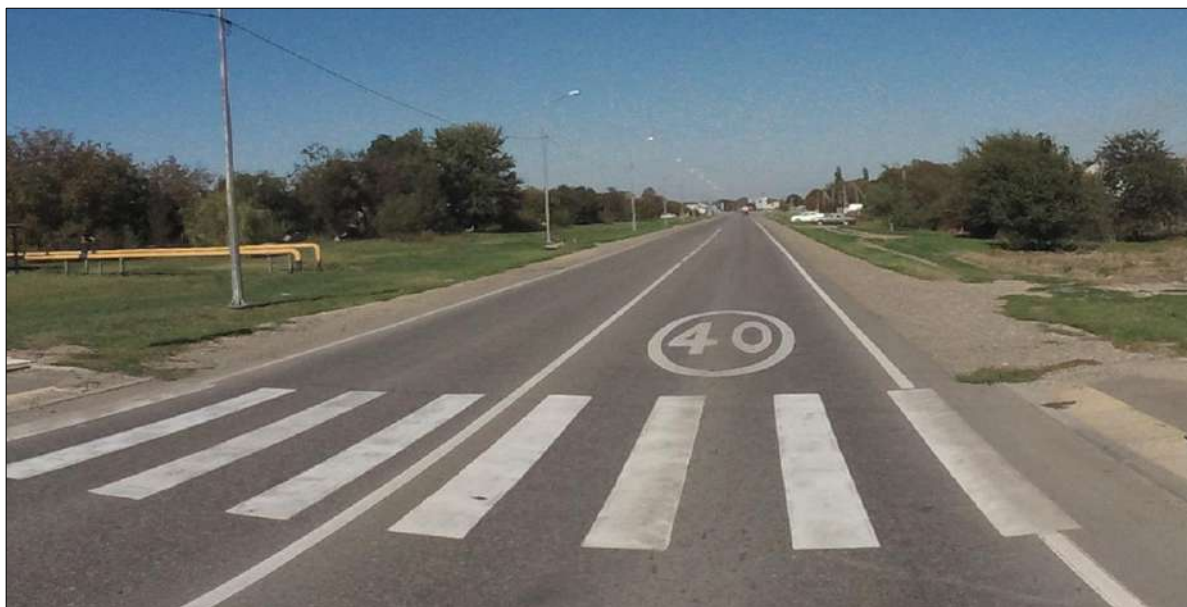
Рисунок 1.7.4 – Пример эксплуатационного состояния горизонтальной разметки 1.1 (разделяющей транспортные потоки противоположных направлений), 1.2 (обозначающей край проезжей части), разметки 1.14.1 (обозначающей пешеходный переход) нанесённых по ул. Школьная, п.
