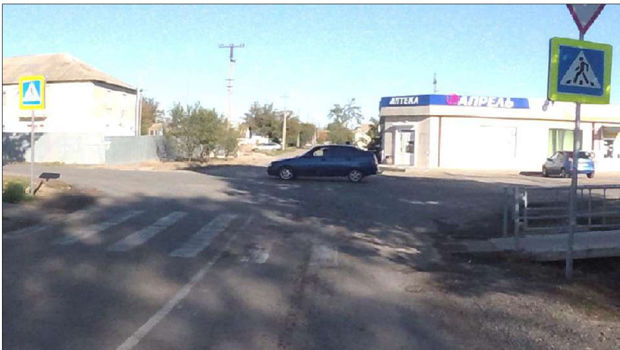
Рисунок 1.7.5 – Пример неудовлетворительного состояния разметки 1.1 (разделяющей транспортные потоки противоположных направлений) и разметки 1.14.1 (обозначающей пешеходный переход) нанесённых пер.
