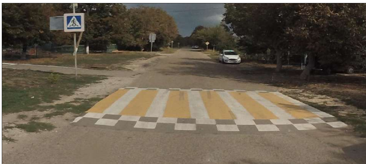
Рисунок 1.7.7 – Пример эксплуатационного состояния искусственной неровности монолитной конструкции, расположенных по ул. Таманской Дивизии в ст-це Запорожская
